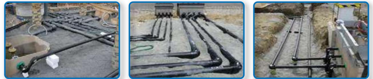
フレキシブル樹脂配管 (地下埋設用配管)
