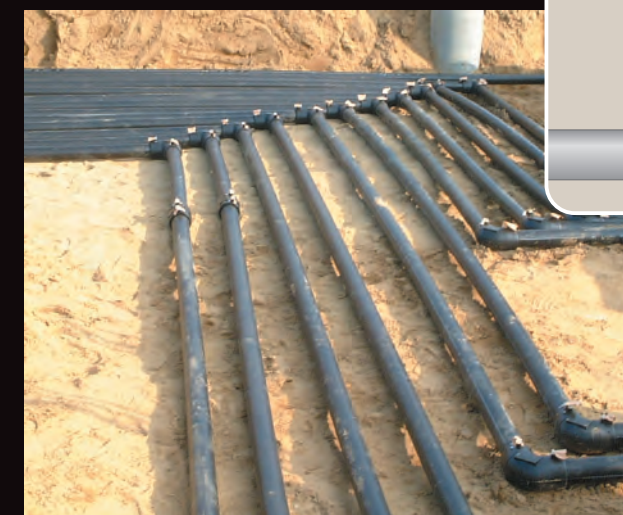
定尺管の施工例
