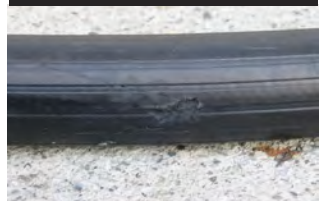
④ はく離：表面のはく離
