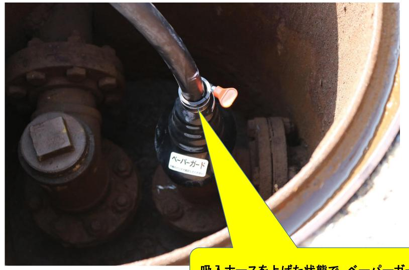
吸入ホースを上げた状態で、ベーパーガードの 取り付けネジでしっかりと固定する
