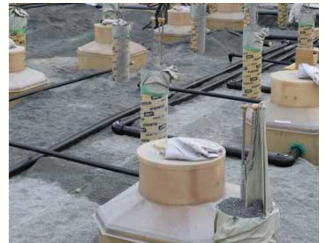
地下埋設用フレキシブル樹脂配管システム
