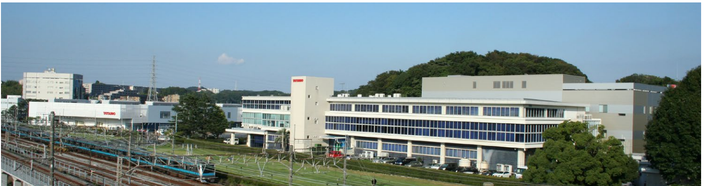
横浜工場 (JR東海道線大船駅付近) Yokohama Plant
